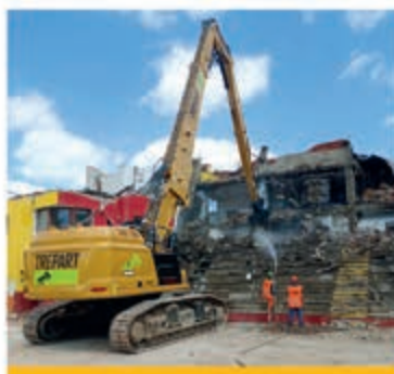
Společnost TREPART se zaměřuje na demolice od roku 1999
