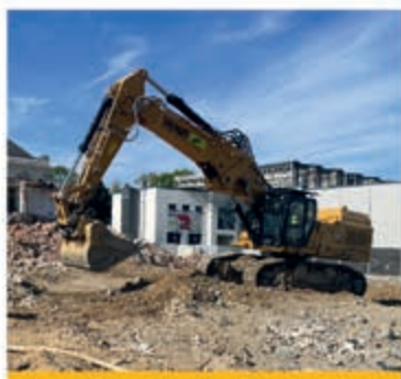
Demoliční Cat 352 v Jihlavě pracoval devět až deset hodin denně
